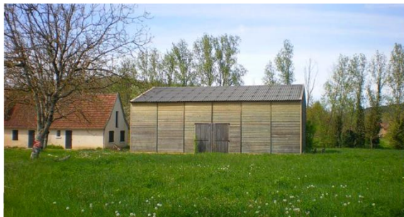
Toitures foncées et bardage bois brut : des possibilités pour une intégration réussie
