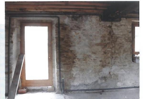
Pose des canalisations de balayage en haut et en bas des murs.
