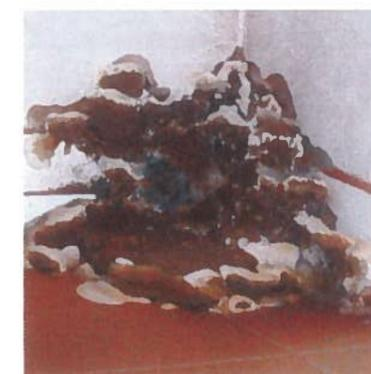
En Bretagne, il y a quelques années, la mэрule a fait des ravages, suite à des transformations de bâti ancien en résidences secondaires, avec imperméabilisation des parois (par le ciment), pose de fenêtres et menuiseries hermétiques, installation de chauffage. Après le week-end à chauffer la maison, la famille repartait en ville, laissant le champ libre à un développement rapide de la mэрule!
